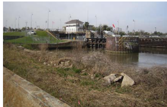
Photograph 4-1. IHNC Lock Site
